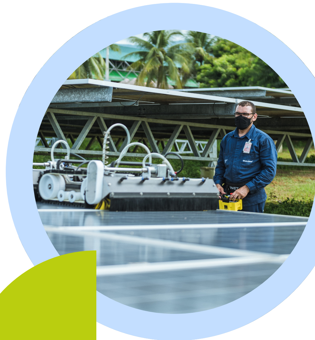
Antônio Fernando Vieira Franca - Electricista de Mantenimiento Industrial - Sobral (CE)
